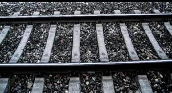
Sous les rails, il y a des traverses sur lesquelles sont posés les rails.
